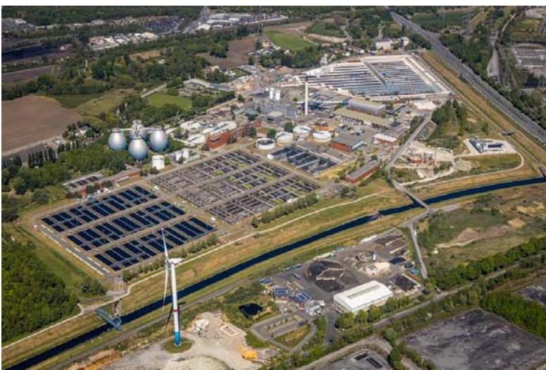
Die Kläranlage Bottrop wird zum Kraftwerk - Quelle: EGLV
